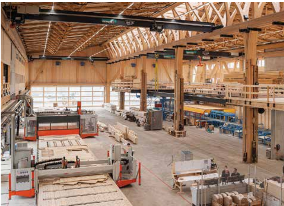
Auf der TechnoWood Produktionsstrasse am Standort Frauwis in Saland entstehen die Elemente für den Holzbau.
